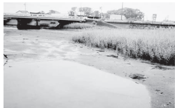
図 3-7c. 調査地点 佐奈川の状況 (2004年3月7日 河口部のアシ原を南から撮影)
