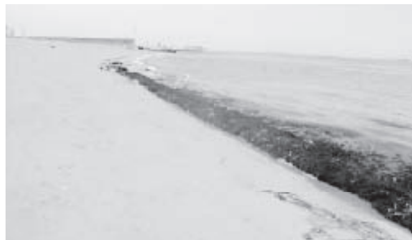
図 3-29b. 調査地点 吉崎の状況 (2002 年 7 月 11 日 吉崎の砂浜を北に向かい撮影)
